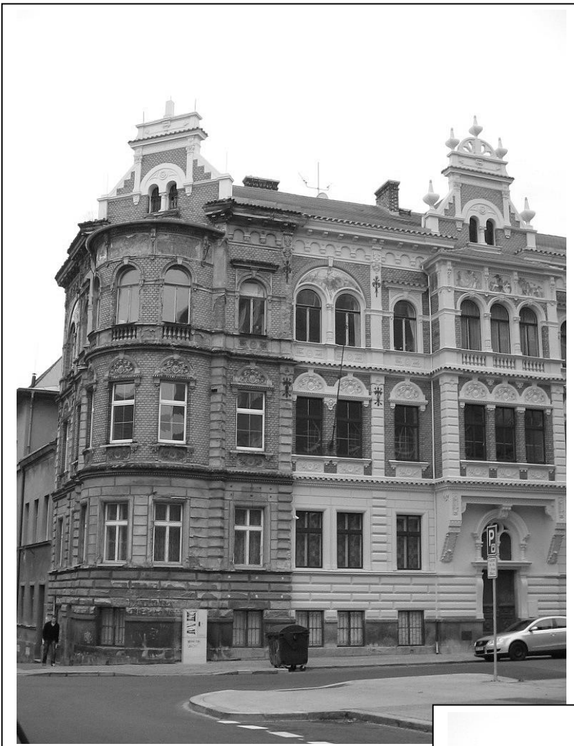
Nárožní část průčelí do Petákovy a Jagellonské ulice
