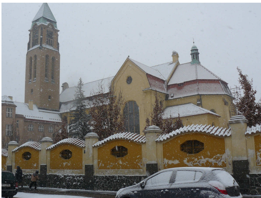
Kostel Panny Marie Růžencové, Jiráskovo náměstí 30, Plzeň, Severovýchodní a jižní pohled na obnovené úseky střechy nad kněžištěm z prejzové krytiny nemovitá kulturní památka rejst. č. 49719/4-5157 ÚSKP.
