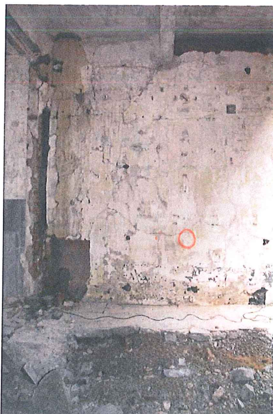
Foto 6 – Omítka pod níž se nachází tepelná korkolitová izolace
