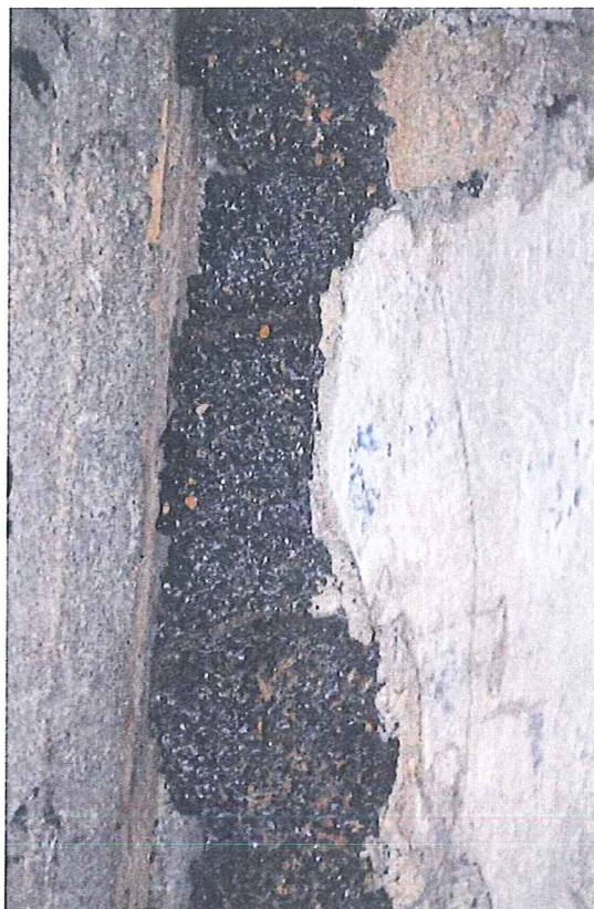
Foto 2 – Detail korkolitu na silikátovém nosném podkladu
