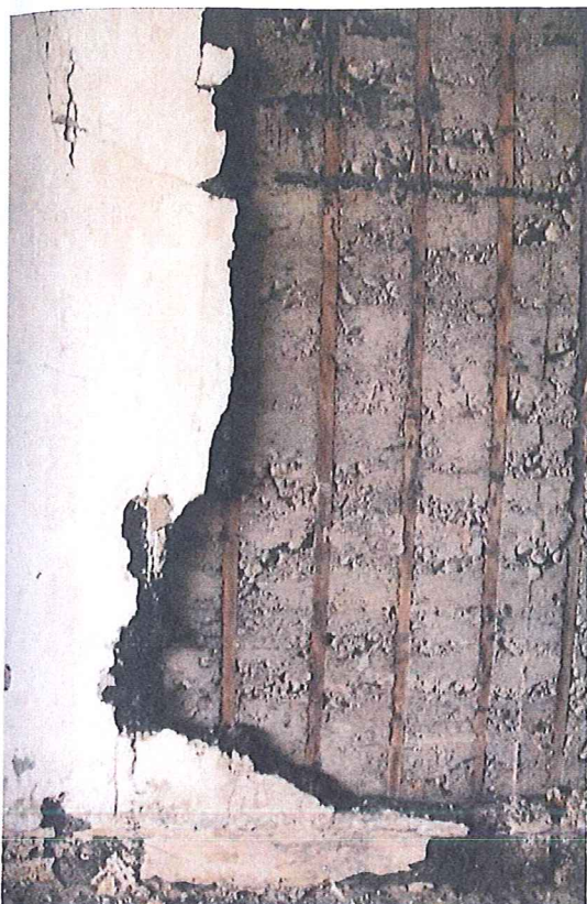
Foto 1 – Část odbouraného korkolitu a odhalení nosného dřevěného roštu
