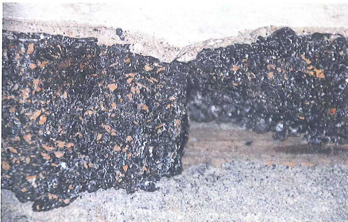
Foto. 3 – Detail korkolitu na silikátovém nosném podkladu
