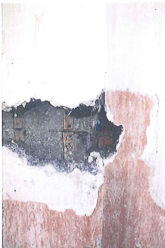
Foto 8 – Sonda odhalující přítomnost korkolitu a zpracování konstrukční oceli
