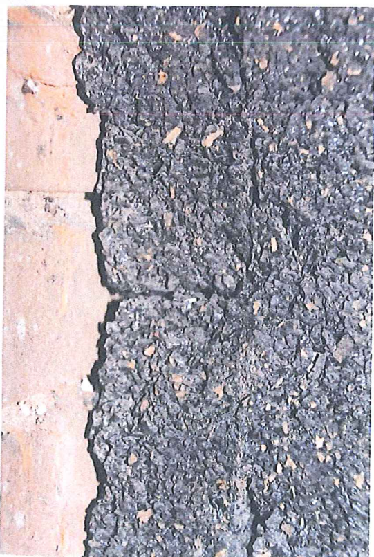
Foto 5 – Korkolit je kotven k železobetonu i ke zdivu
