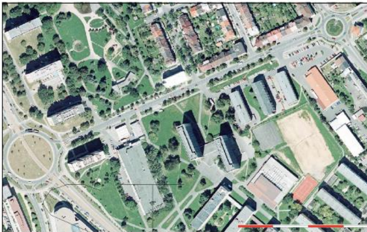
STÁVAJÍCÍ STAV ÚZEMÍ - LETECKÝ POHLED
