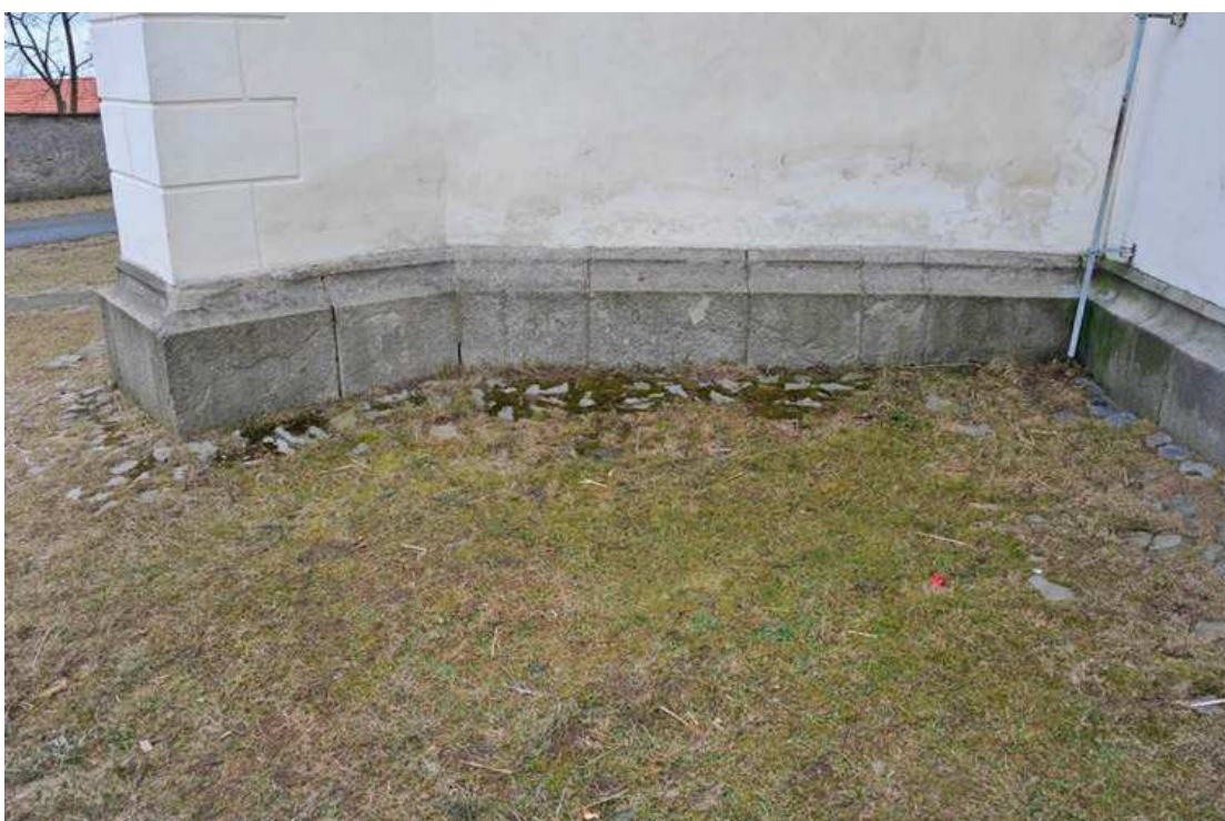
Kostel sv. Petra a Pavla, Budilovo náměstí, Plzeň-Litice, pohled na severní vstup a spodní část západního štítu, nemovitá kulturní památka rejst. č. 29444/4-231 ÚSKP.
