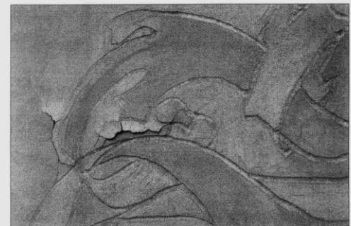
▷ Detail na rozvolnění vrchní omítkové vrstvy sgrafita
