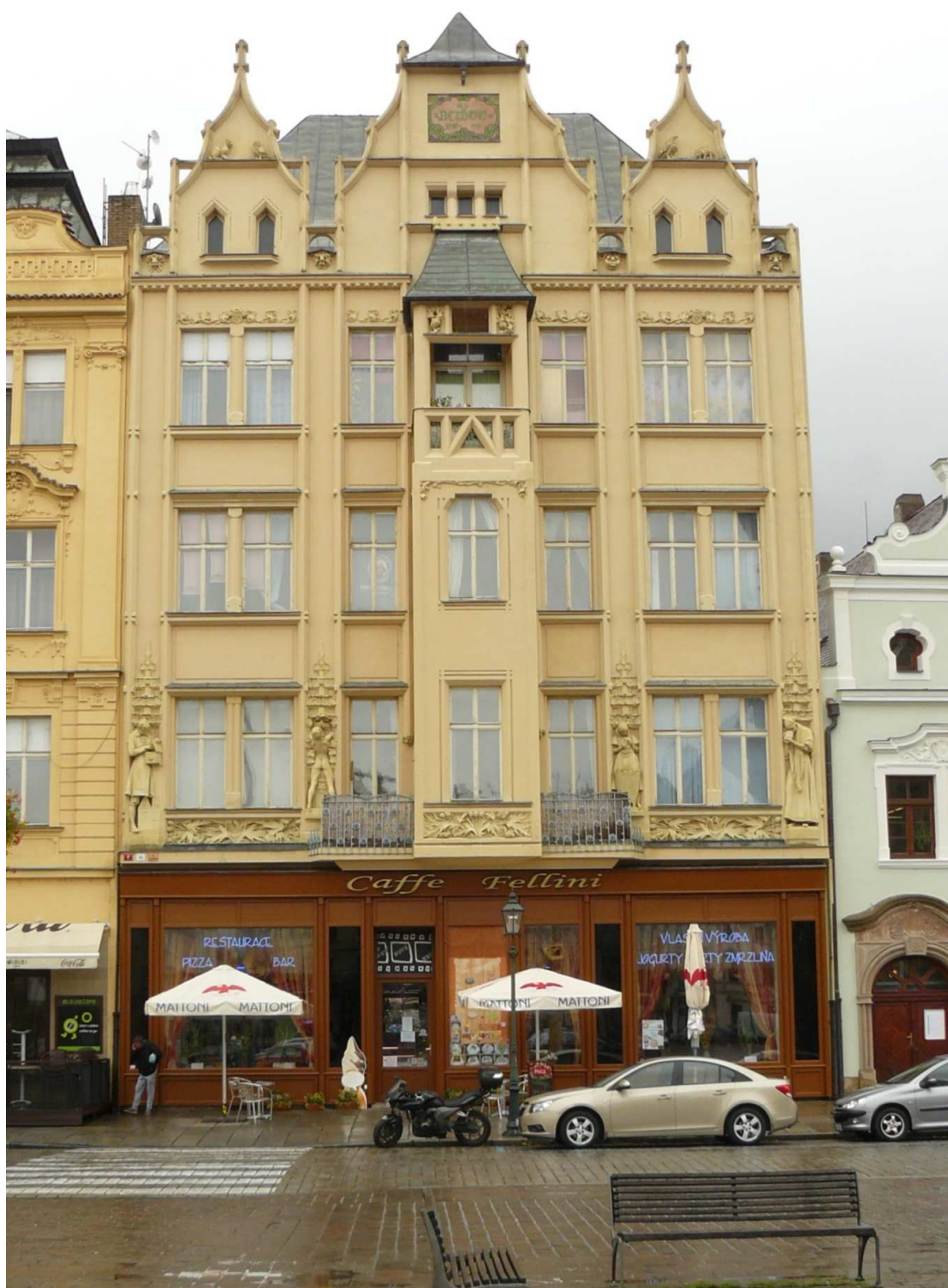
Měšťanský dům U Bezděků čp. 95, náměstí Republiky 7, Plzeň, současný vzhled hlavního průčelí, nemovitá kulturní památka, rejstř.č. ÚSKP 44247/4-4692,
