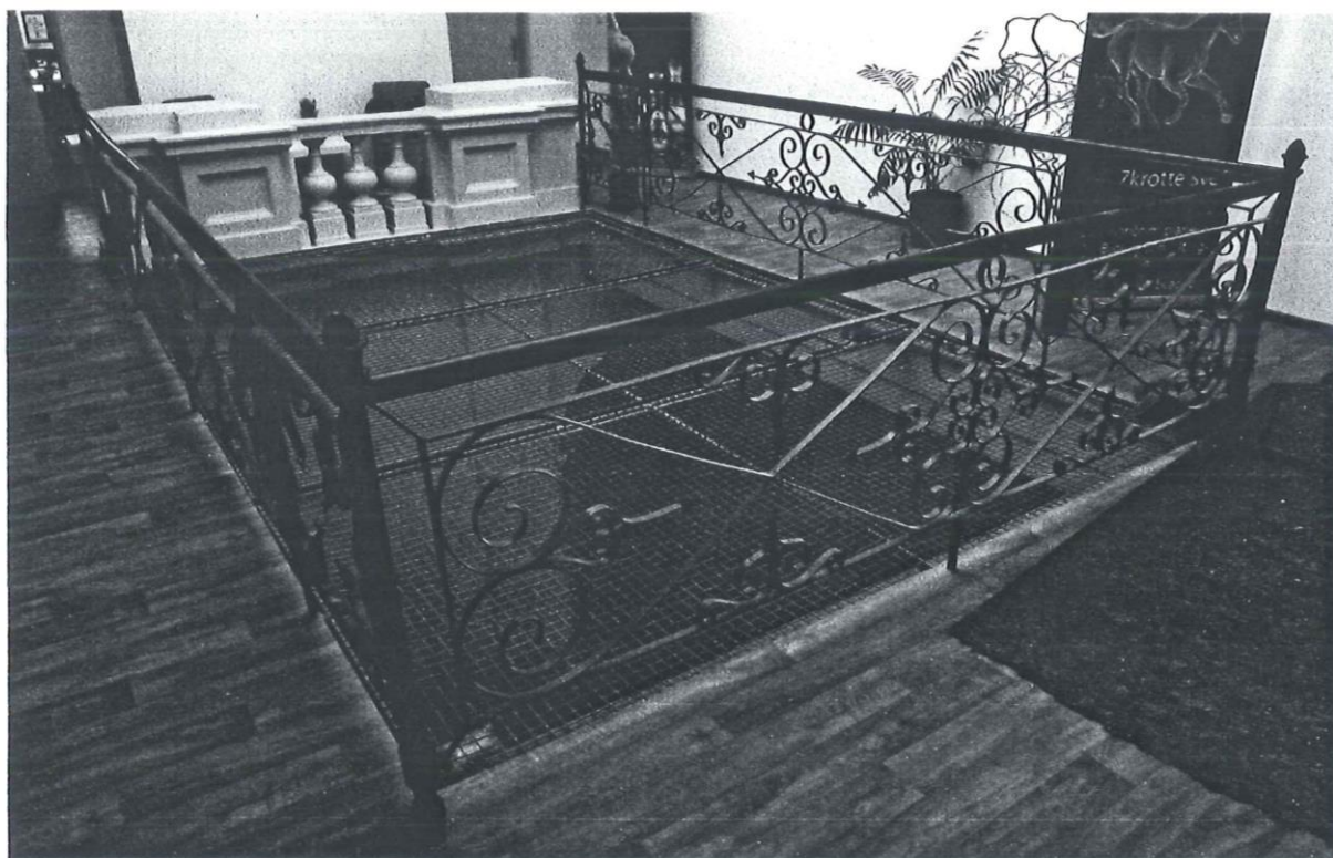
Obrázek 1: Zábradlí ochozu v podkroví
