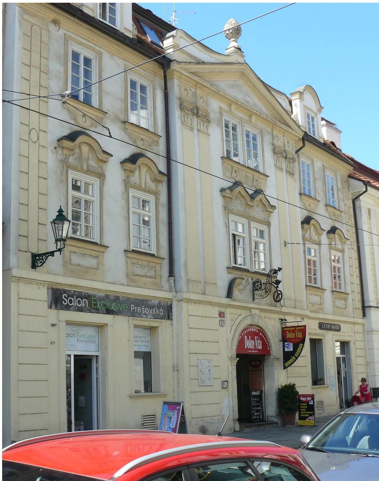
Měšťanský dům čp. 170, Prešovská 5, Plzeň, hlavní uliční pohled, nemovitá kulturní památka rejst. č. ÚSKP 14051/4 – 4407.
