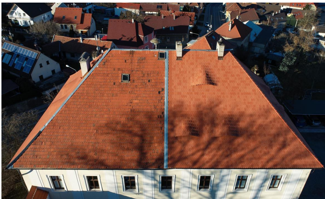
Budova fary čp. 1, Budilovo náměstí 2, Plzeň-Litice, jihovýchodní pohled na budovu fary a na střechu z nadhledu, nemovitá kulturní památka, rejstř. č. 34221/4-1215 ÚSKP
