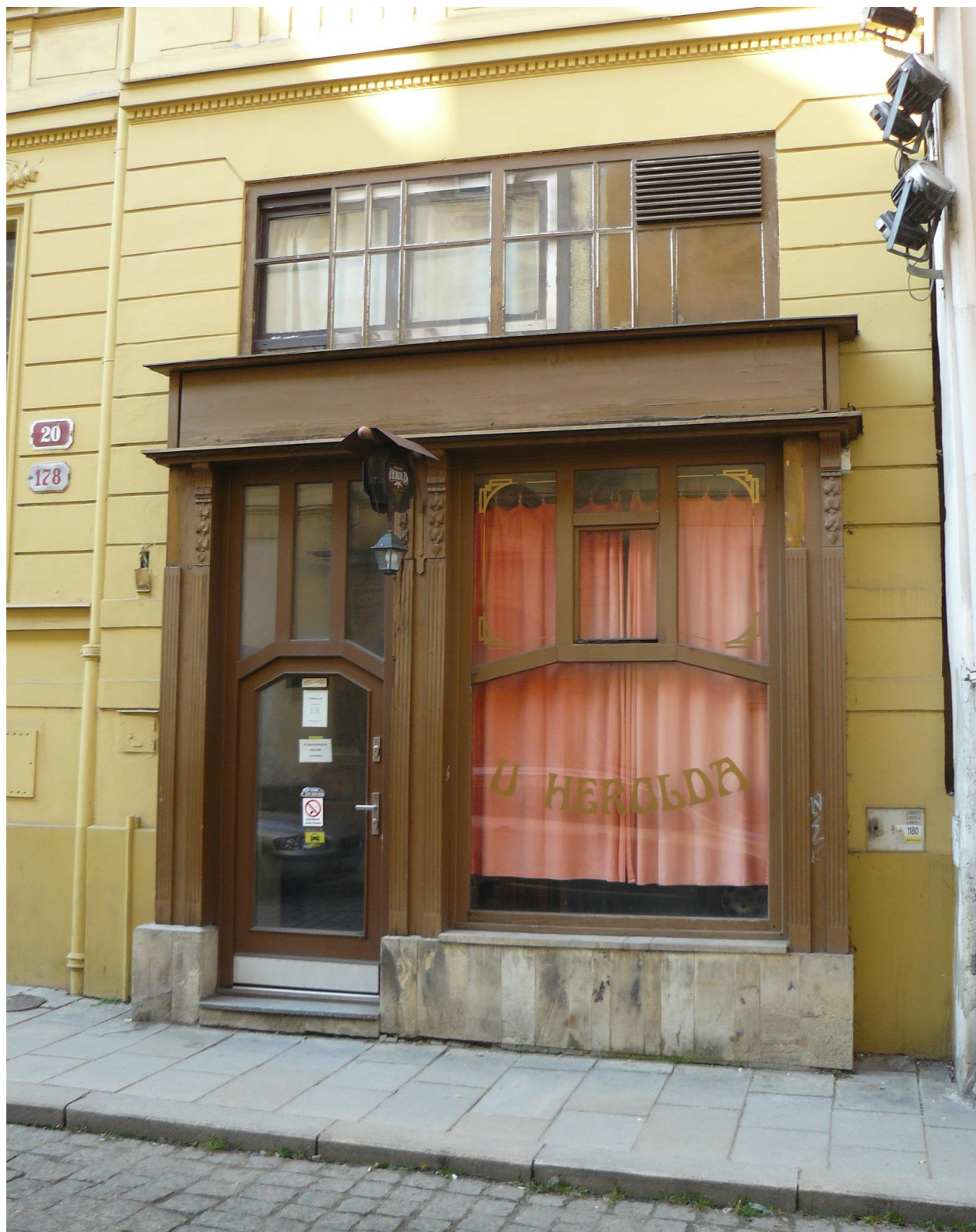
Činžovní dům čp. 178, Bezručova 20, Plzeň, celkový pohled na dřevěný výkladec, nemovitá kulturní památka rejst. č. 44269/4-4712 v ÚSKP
