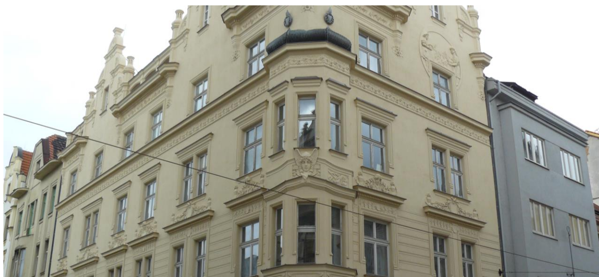
Městský dům čp. 273, Sedláčkova 28, k. ú. Plzeň, detail fasády u zlatnictví soubor oken 4. NP uličních průčelí, nemovitá kulturní památka rejst. č. 13524/4-4829 ÚSKP.
