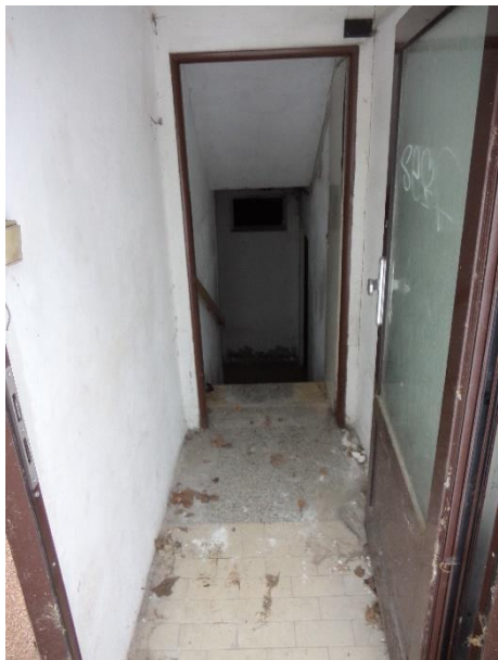
Nebytová jednotka č. 1119/25, Sokolovská 121
